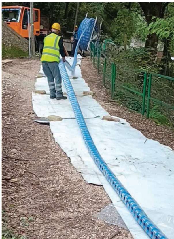
Figura 3. Il Cantiere di varo – La tubazione da inserire viene preparata nel viale trasversale al Ponte
