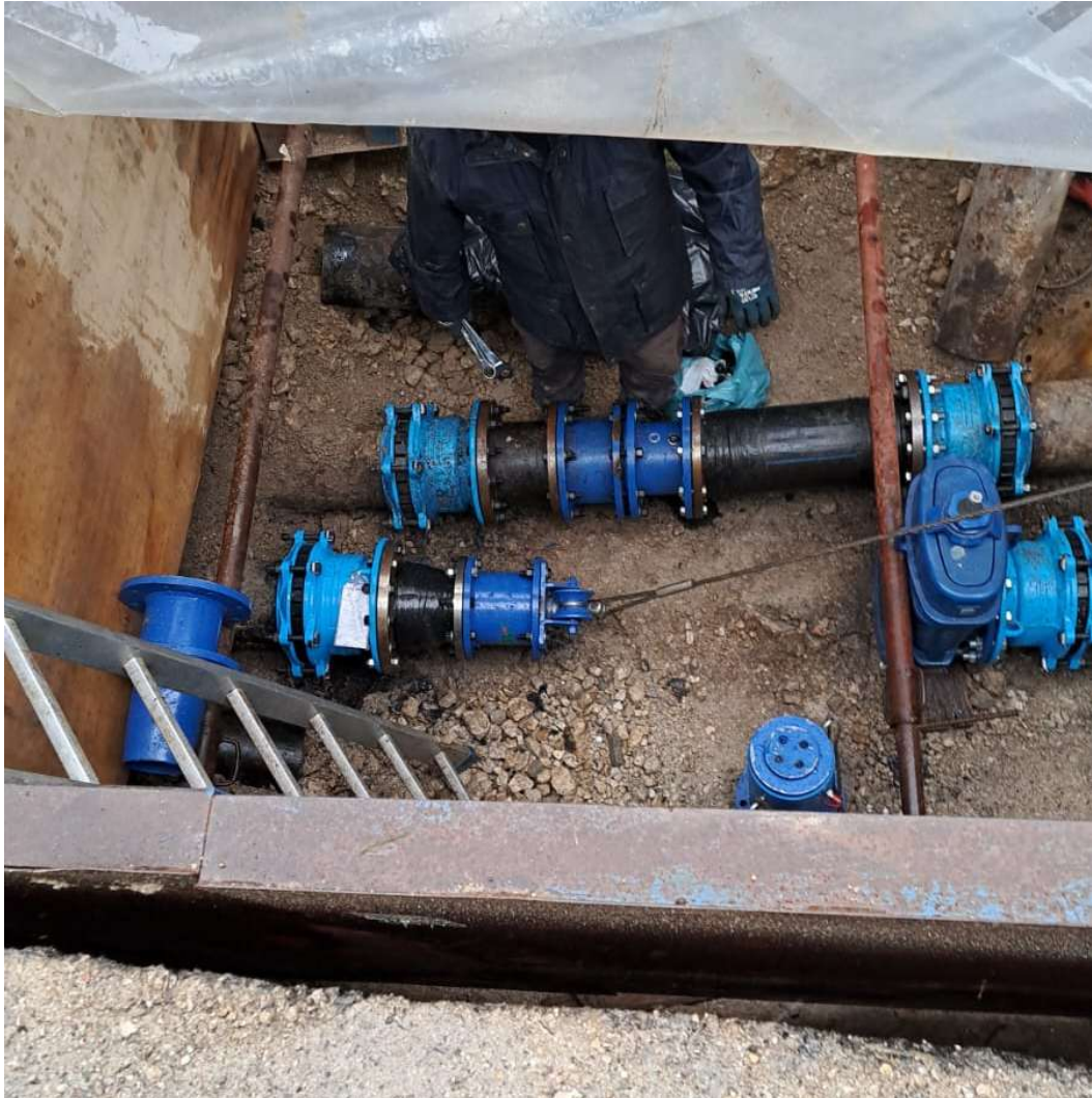
Figura 4. Il Cantiere di tiro – La tubazione viene tirata nell'area di scavo di Colle S. Erasmo
