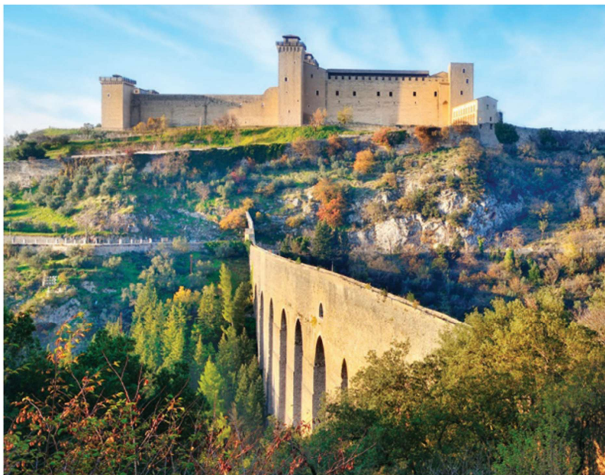
Figura 1. Il Ponte delle Torri – Simbolo della Città di Spoleto
